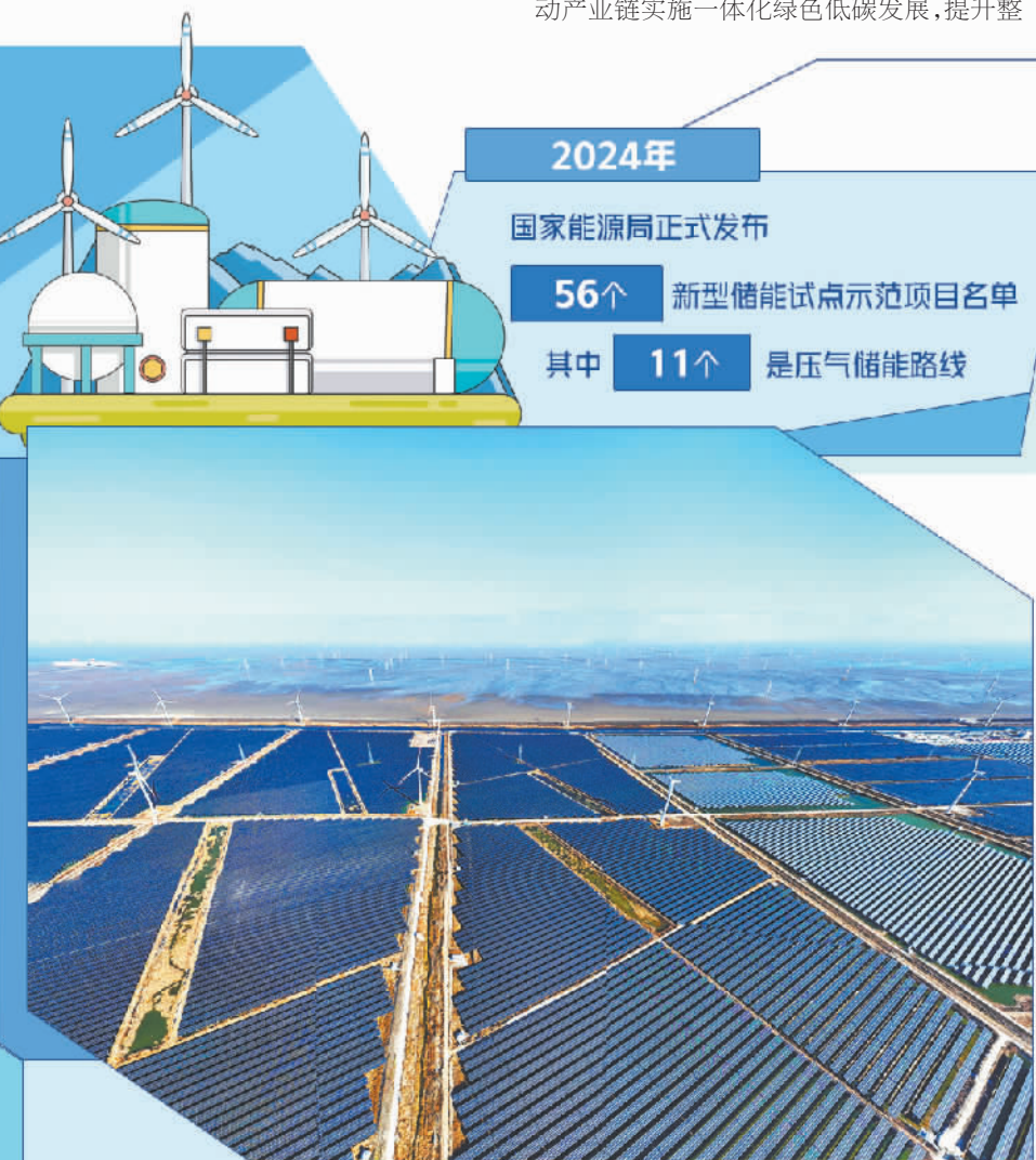
近日,国内首个集光伏发电、制氢加氢和储能电站于一体的“光氢储一体化”项目,在江苏省如东县成功并网发电。
