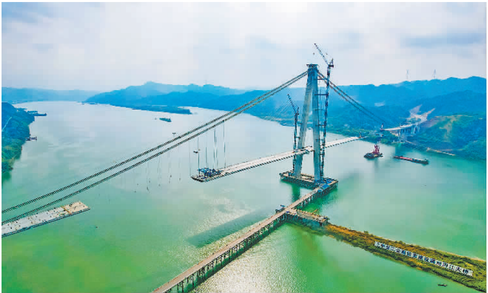
近日,在得江广西梧州藤县濠江镇河段,得江特大桥正加紧建设。作为平岑高速公路的控制性工程之一,大桥建成后,将成为打通桂东地区连接粤港澳大湾区的一条重要通道,对优化广西高速路网布局、加快地方经济发展具有重要意义。 周火文摄(中经视觉)
