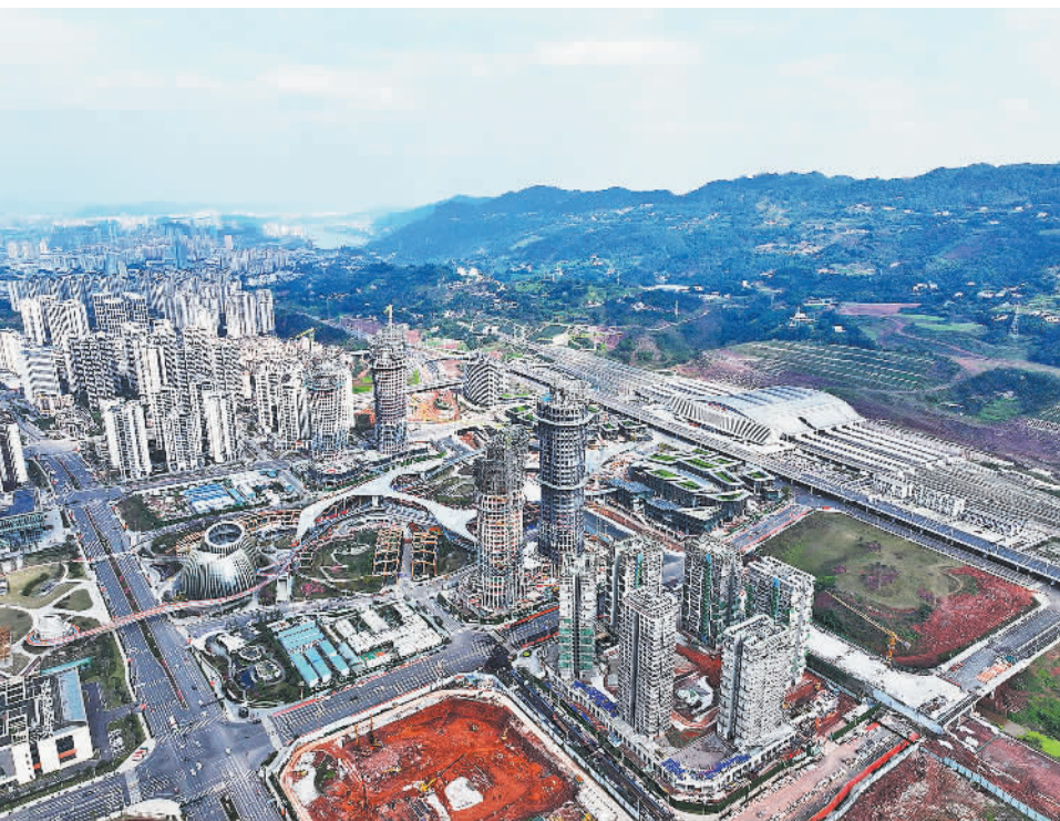
2月10日,位于四川省宜宾市叙州区的渝昆高铁宜宾站前广场项目施工现场,工人们正加紧作业。项目建成后,将形成功能完备、生态宜居的独立片区体系以及独具特色的城市门户形象展示区。 兰 锋摄(中经视觉)
