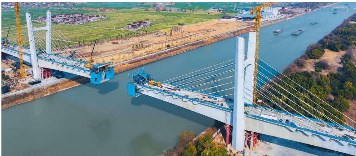
2月19日拍摄的沪渝蓉高铁泰州段桥梁工程施工现场。目前,该工程全面进入箱梁架设阶段,箱梁架设计划于10月全部完成。
