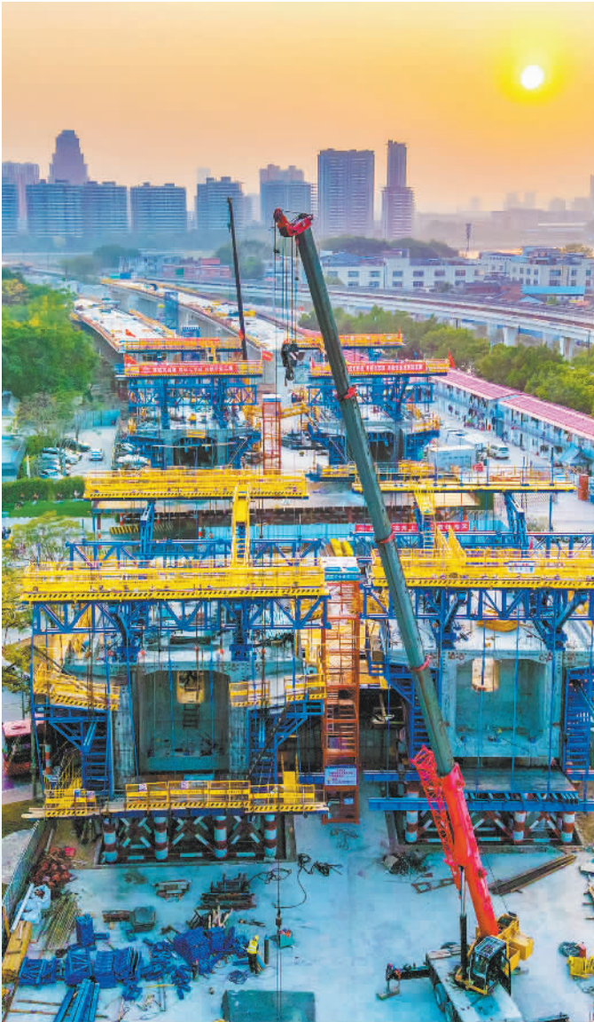
▼2月15日,湖北省十堰市西十高铁汉江特大桥施工正酣。 古建教摄(中经视觉)
