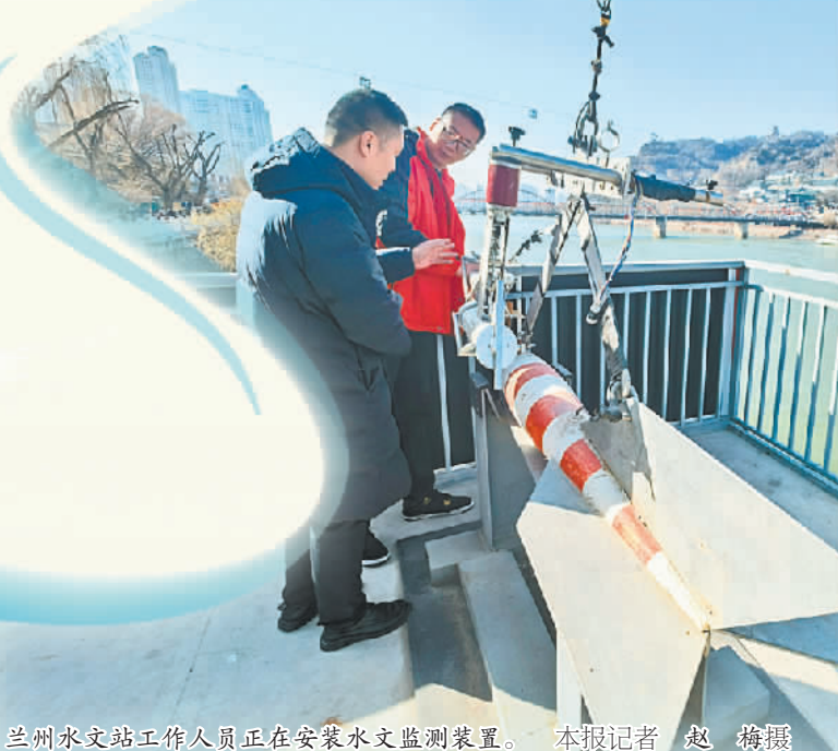
兰州水文站工作人员正在安装水文监测装置。 本报记者 赵梅摄
