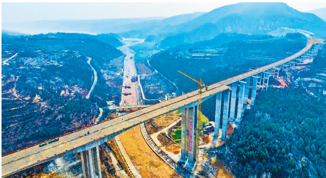
河南省洛阳市新安县济新高速公路施工现场,工人正加紧施工,全力冲刺年底全线通车目标。济源至新安高速公路项目是河南省高速公路重点建设项目之一。项目建成后,将与新伊、菏宝、连霍高速相连,进一步完善豫晋高速公路网,密切豫晋两省洛阳、济源、运城间的交通联系,有效带动沿线旅游开发、经济发展。 张怡照摄(中经视觉)
