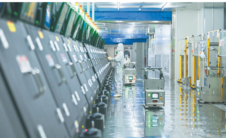
近日,江西兆驰半导体有限公司生产车间内,自动导向搬运车来回穿梭作业。近年来,江西南昌高新区不断加快科技创新和数字化转型升级步伐,全力构建以LED和移动智能终端为主的电子信息产业集群,形成从核心设备、衬底材料、外延芯片、封装到终端应用的产业链。 李 勃摄(中经视觉)
