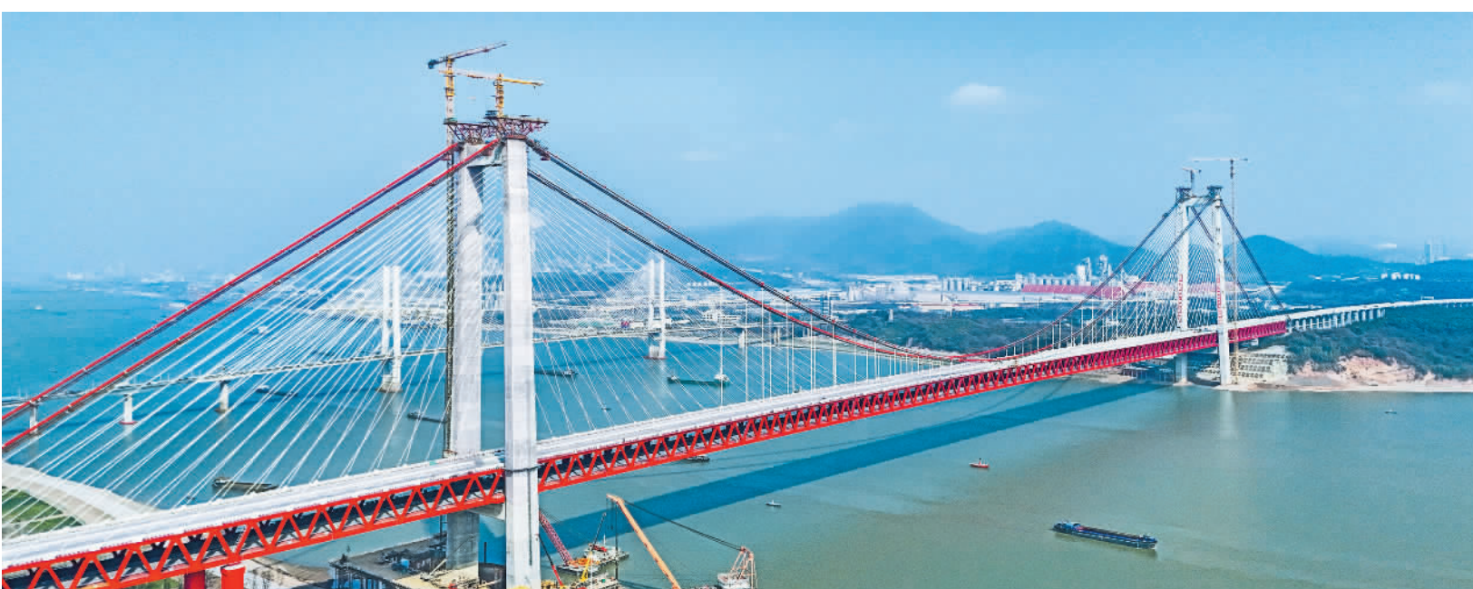
图为2月27日拍摄的安徽省铜陵市G3铜陵长江公铁大桥。该项目预计7月达到通车条件,对于加快区域协调发展和长三角互联互通具有重要意义。 傅著传摄(中经视觉)
