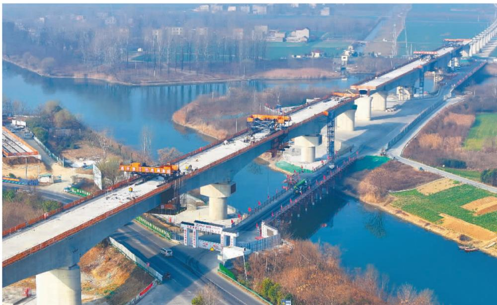
2月27日，安徽省亳州市利辛县马店孜镇境内的阜淮铁路利辛西沱河特大桥顺利合龙。阜淮铁路正线全长约142.5公里，设计时速350公里，大桥顺利合龙为沿线架梁和后续工程推进奠定了基础。
