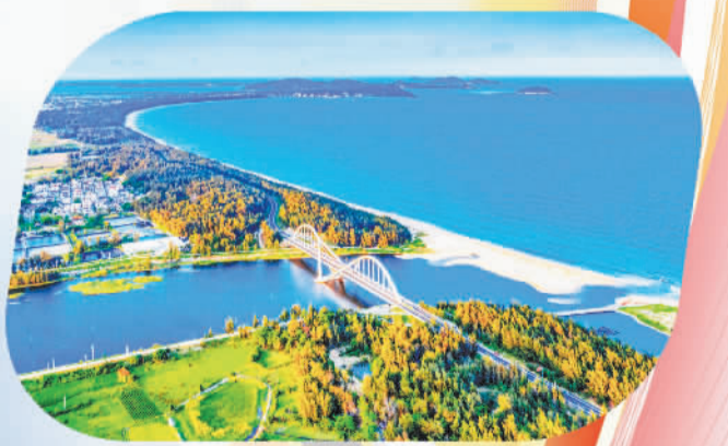
邮储银行贷款支持海南环岛旅游公路建设
