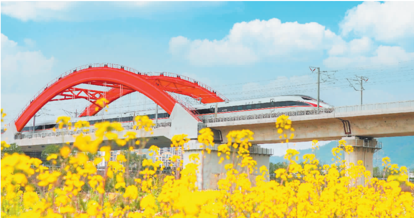
赣深高铁通车后,赣州正式融入粤港澳大湾区2小时经济生活圈。图为复兴号驶过龙南特大桥
