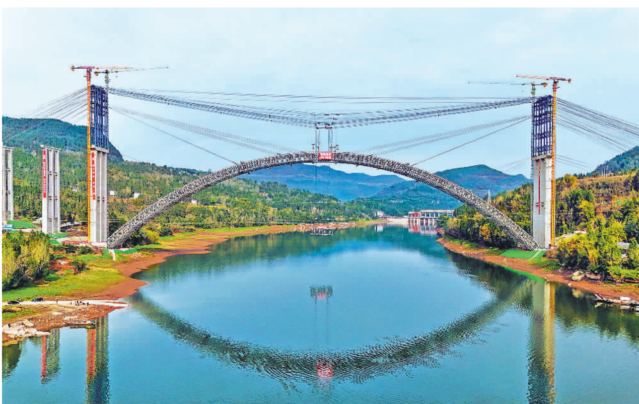
3月6日,四川省巴中市平昌县,镇广高速云台通江河特大桥主拱完成合龙。镇广高速北连陕西、南接重庆,建成后将成为西安至重庆最快捷的高速公路,对完善区域路网、支持成渝地区双城经济圈建设等具有重要意义。
