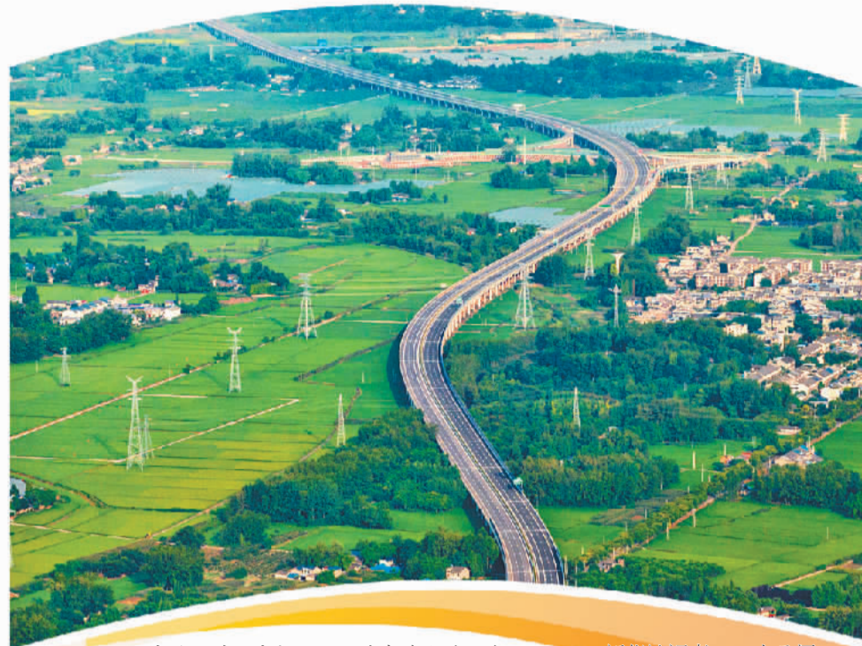
俯瞰四川天府新区至环坝高速公路一角。
