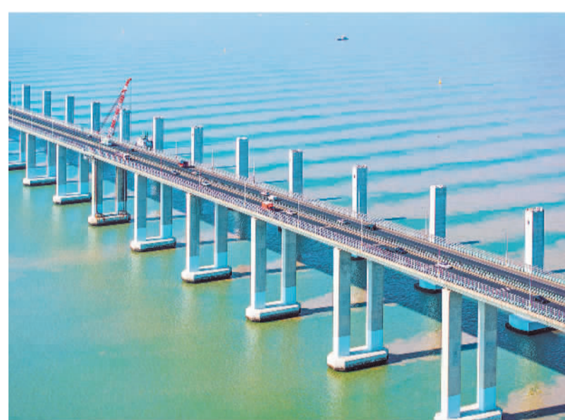
3月17日，浙江省宁波市象山港跨海大桥施工现场一派繁忙。该大桥是国内首座市域（郊）铁路跨海大桥，建成后承担宁波主城区至象山县的中长距离出行功能。胡学军摄（中经视觉）
