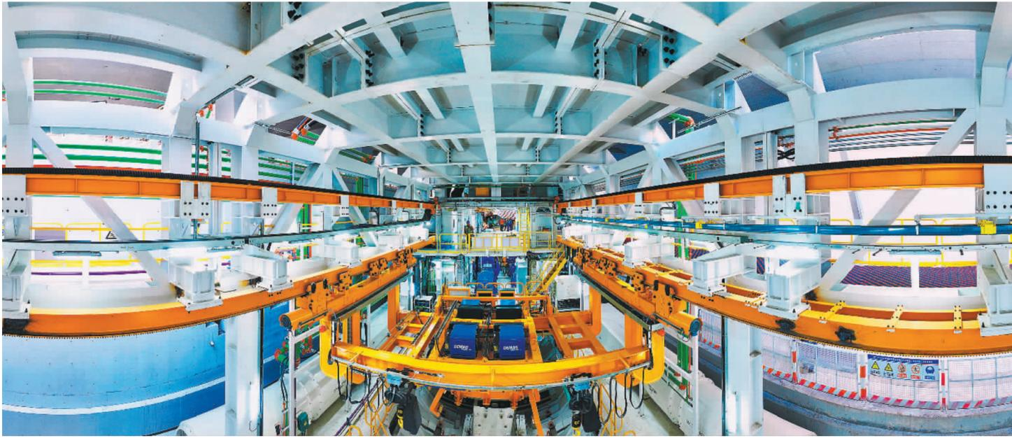
◀3月18日,位于江苏省南通市的海太长江隧道项目顺利完成盾构首环负环管片整体定位拼装。该隧道是目前国内距离最长、断面最大的水下盾构隧道。
