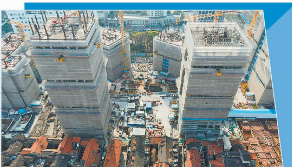
上海市大力实施城市更新,老旧小区改造,全市完成零星旧改项目13.6万平方米。图为上海市黄浦区上海壹号院项目施工现场。新华社记者 方喆摄
