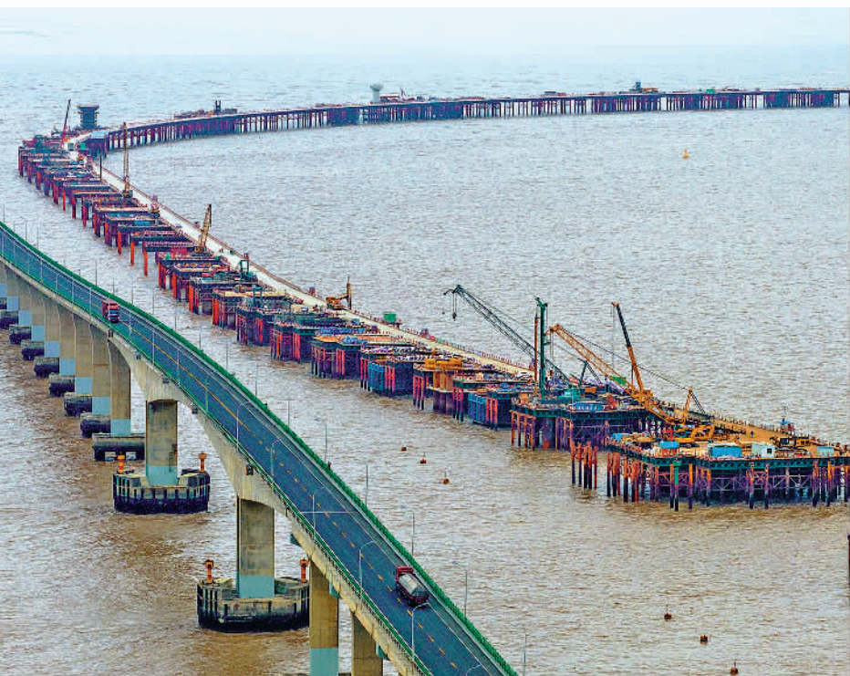
3月31日，浙江省临海市头门港铁路跨海特大桥建设现场，工人在抓紧施工作业。头门港铁路跨海特大桥全长12公里，工程完成后，将进一步完善台州港口集疏运体系，激活金台铁路货运运能。潘侃俊摄（中经视觉）
