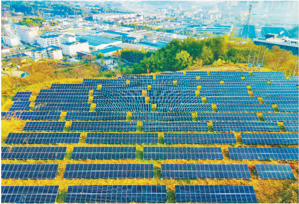
4月8日,在安徽省安庆市岳西县莲云乡腾云社区,曾经闲置的荒坡上,光伏发电板与企业厂房、山峦等一起构成一幅美丽乡村新画卷。近年来,当地利用日照资源丰富的优势,大力发展清洁能源项目,赋能乡村振兴。吴均奇摄(中经视觉)
