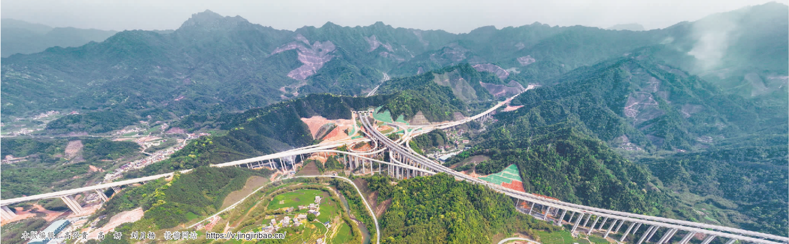
▲4月14日,湖北十堰,西十高 铁汉江特大桥合龙。该特大桥是国 内最大跨度梁桁组合结构斜拉桥, 也是西十高铁全线控制性工程。 古建教摄(中经视觉)
