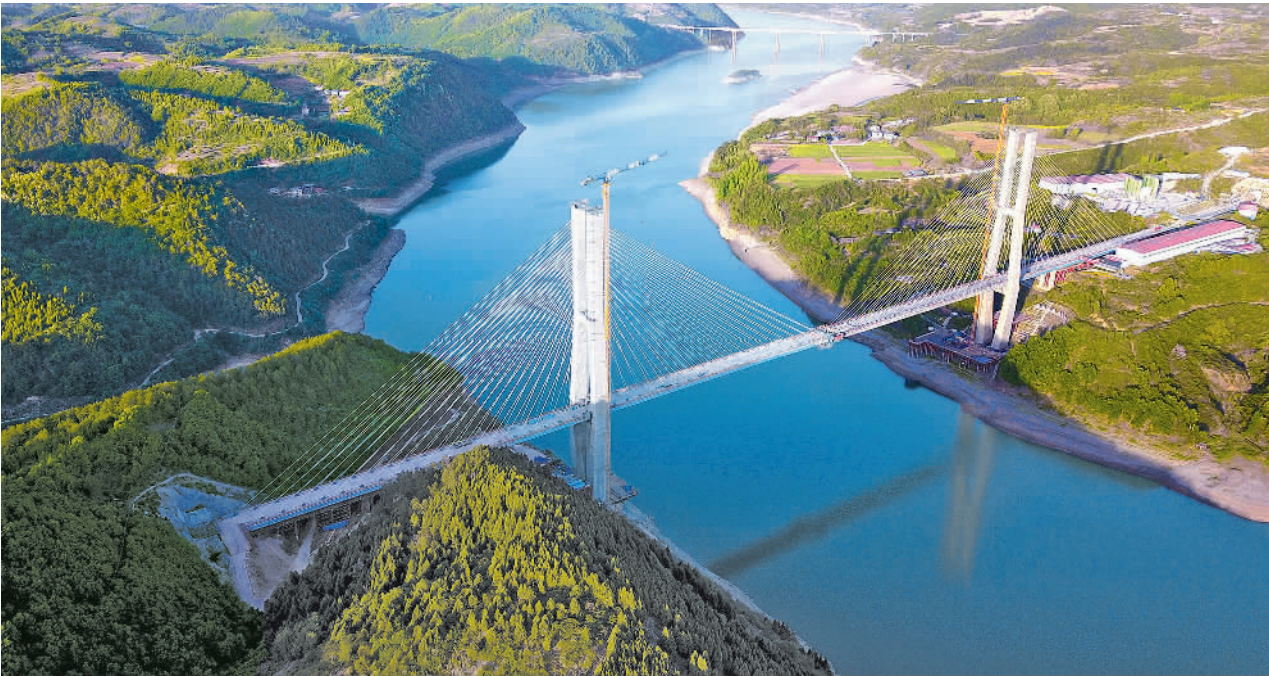
4月14日,湖北省十堰市郧阳区境内的西安至十堰高速铁路汉江特大桥顺利合龙,该桥是国内最大跨度梁桥组合结构斜拉桥。 曹忠宏摄(中经视觉)
