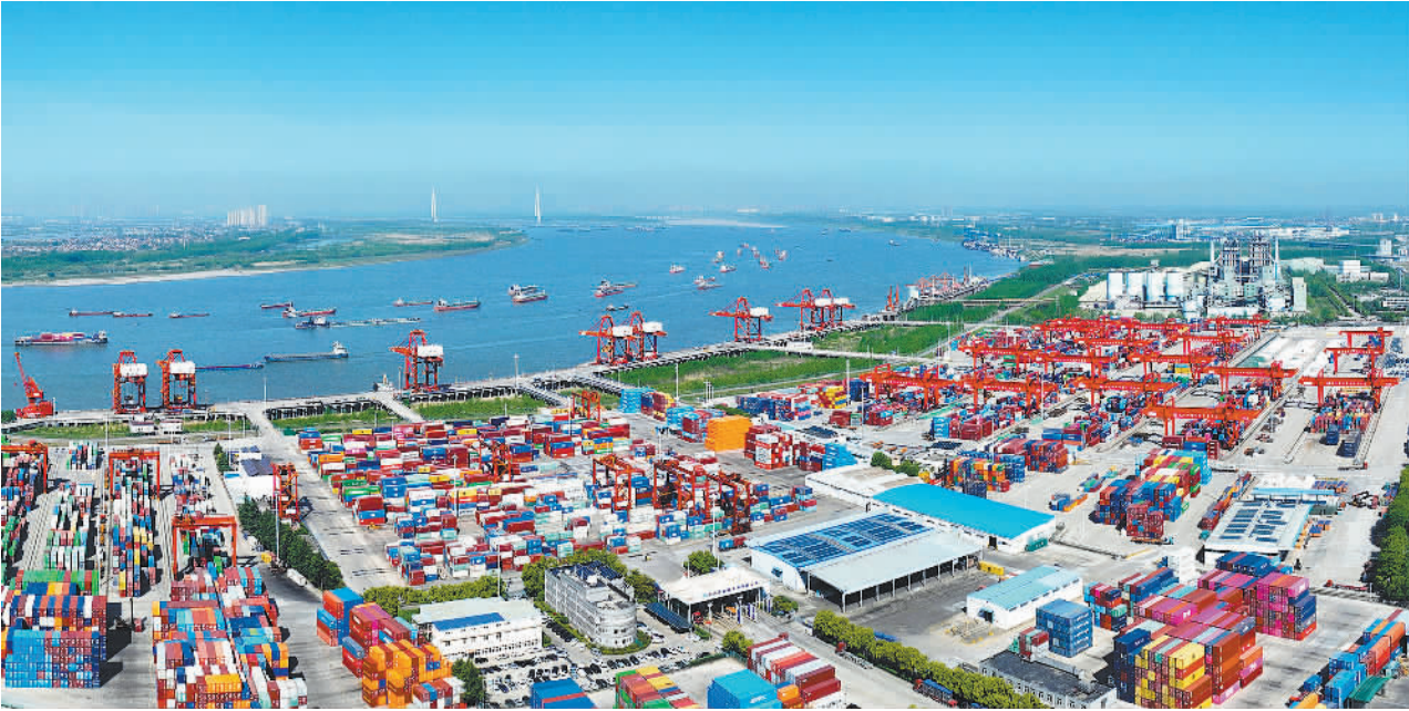
4月15日,武汉阳逻国际深水港一派繁忙景象。作为长江中上游最大的集装箱码头、武汉联通长江经济带与“一带一路”的重要枢纽、国家一类开放口岸,阳逻港已经开通各类集装箱航线35条,多式联运通道42条。海关数据显示,今年一季度,武汉阳逻港直航进出境货物7.99万吨,同比增长189.1%,创历史同期新高。 张兵摄(中经视觉)
