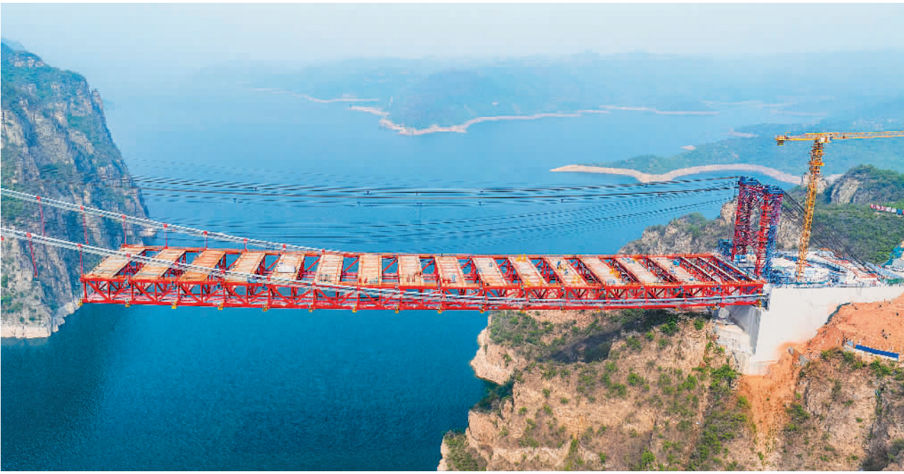
4月19日,河南济源至新安高速公路跨越小浪底库区黄河大桥施工现场一派繁忙景象。该大桥是济新高速公路控制性工程,采用双向六车道设计。李培献摄(中经视觉)
