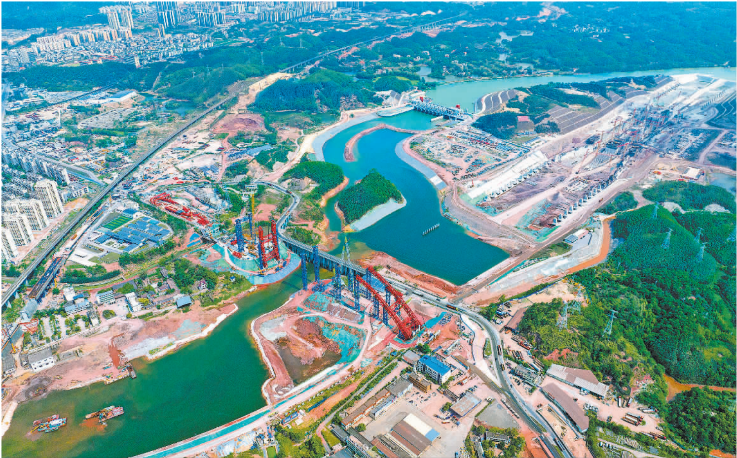
4月23日,位于广西钦州市的平陆运河青年枢纽正在加紧建设中。该项目建成后,将进一步优化广西运输结构,西南地区货物经平陆运河出海较经广州港出海缩短内河航程560公里以上。 何华文摄(中经视觉)
