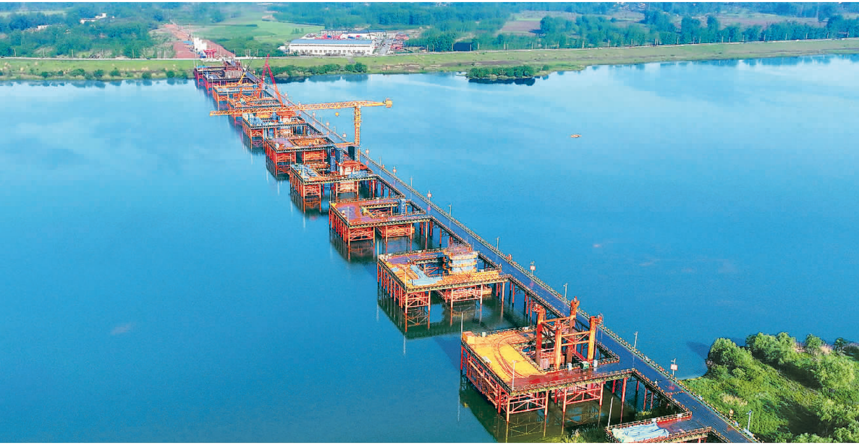
4月23日,安徽省六安市金安区合武高铁六安淠河特大桥施工现场,工人正在进行桥墩桩基施工。合武高铁项目建成后,将进一步优化长江经济带路网布局,便利沿线群众出行,更好服务区域协调发展。
