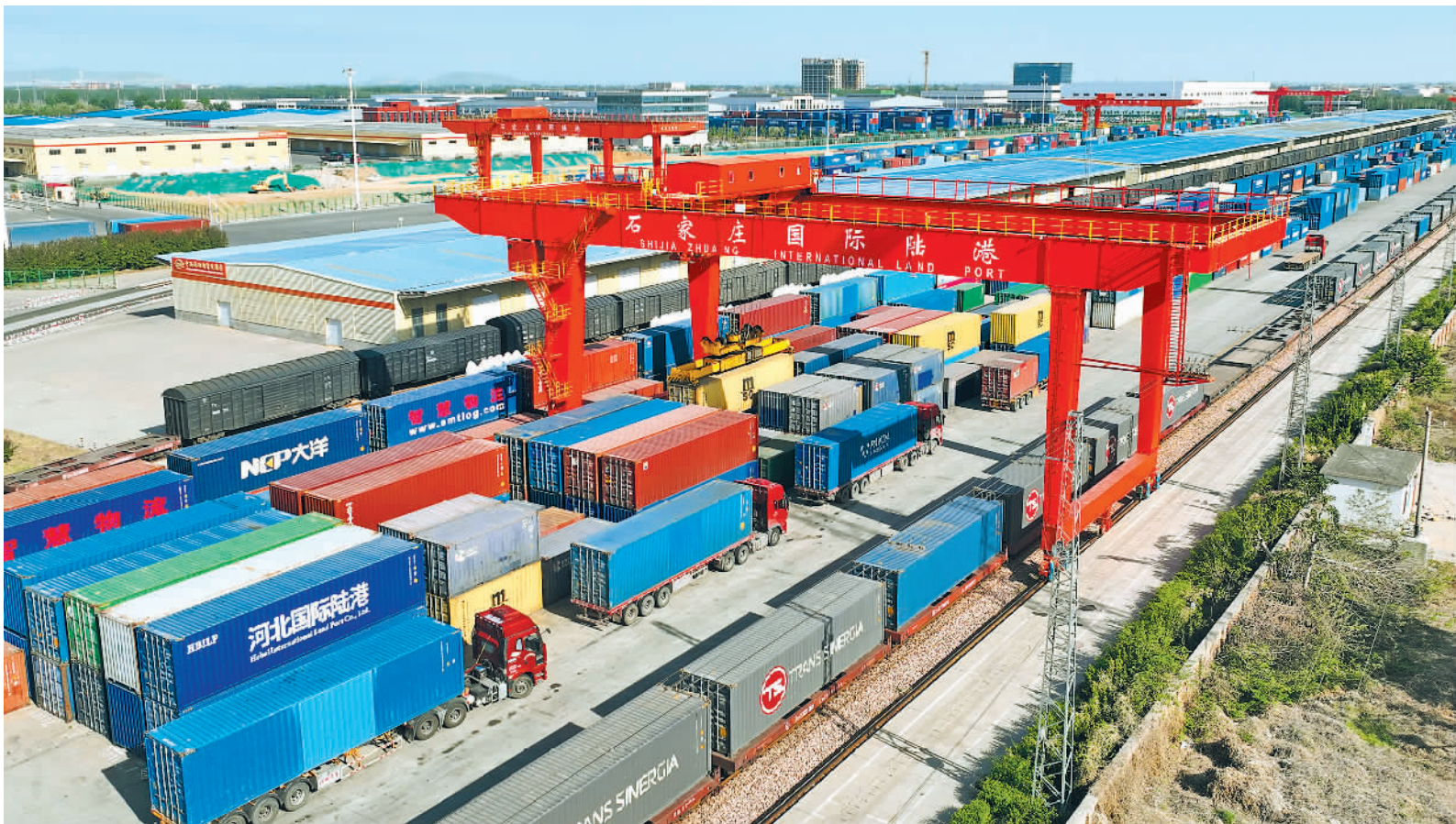
4月24日拍摄的石家庄国际陆港集装箱吊装现场(无人机照片)。
