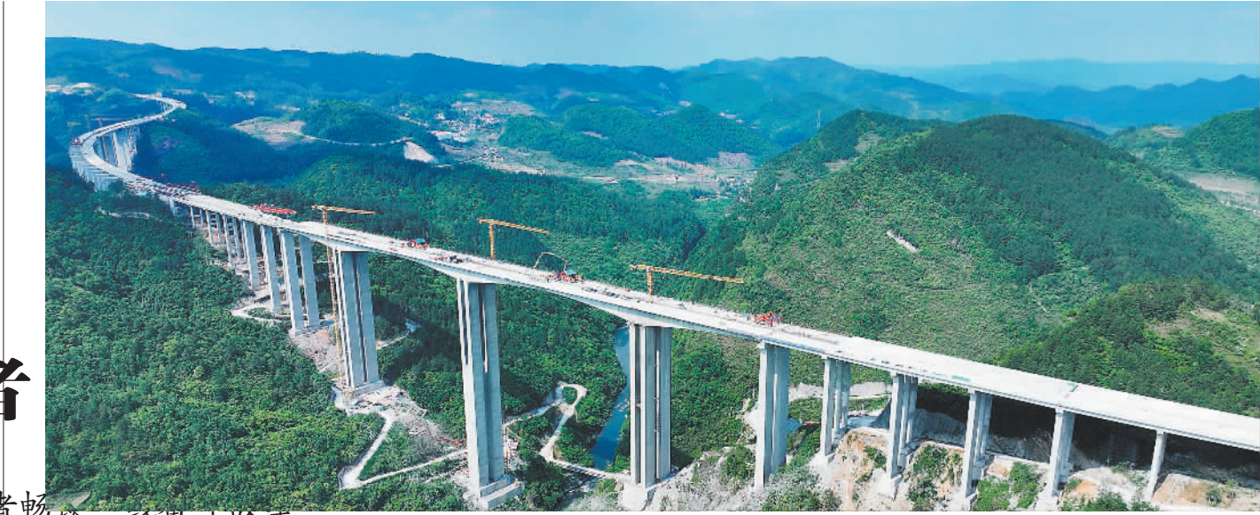
4月28日,位于贵阳市乌当区的贵(阳)平(塘)高速公路南明河特大桥主桥实现合龙。该大桥全长1129.8米,为连续刚构T梁桥,最大主跨180米,最大墩高175米,是贵平高速公路的重点控制性工程之一。 本报记者 吴秉泽摄
