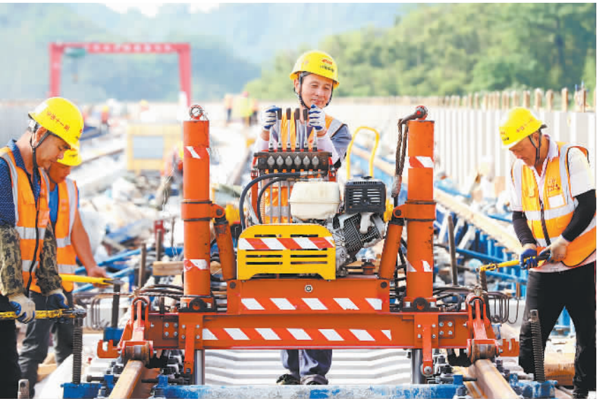
5月1日，浙江省湖州市德清县杭德市域铁路铺轨项目现场，建设者坚守一线，加紧施工作业。 谢尚国摄(中经视觉)
