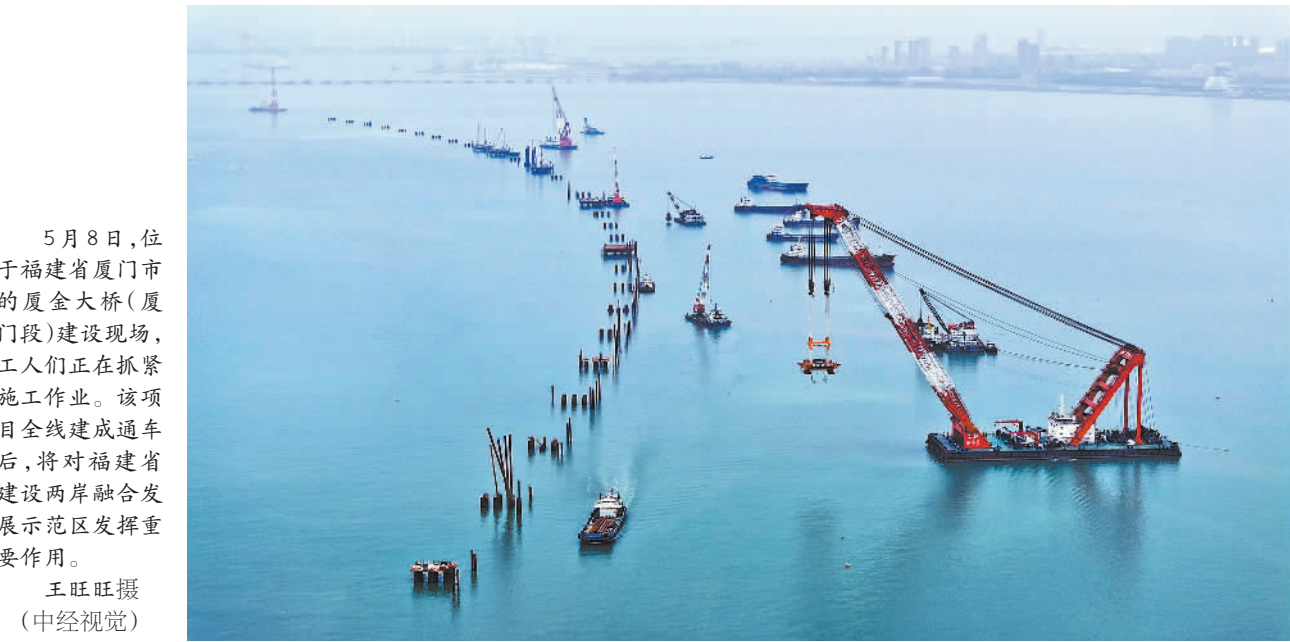
5月8日,位于福建省厦门市的厦金大桥(厦门段)建设现场,工人们正在抓紧施工作业。该项目全线建成通车后,将对福建省建设两岸融合发展示范区发挥重要作用。
