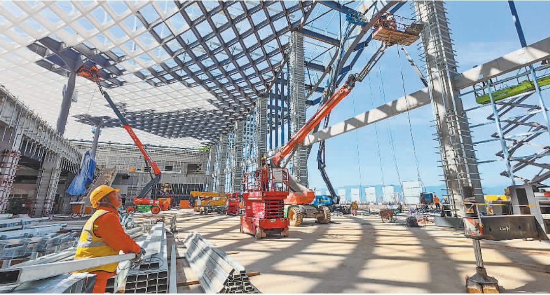
5月12日,工人在贵州省盘(州)兴(义)铁路兴义南站施工。该项目建成后,将大幅缩短黔西南地区与贵阳的时空距离,促进区域经济发展。 刘朝富摄 (中经视觉)
