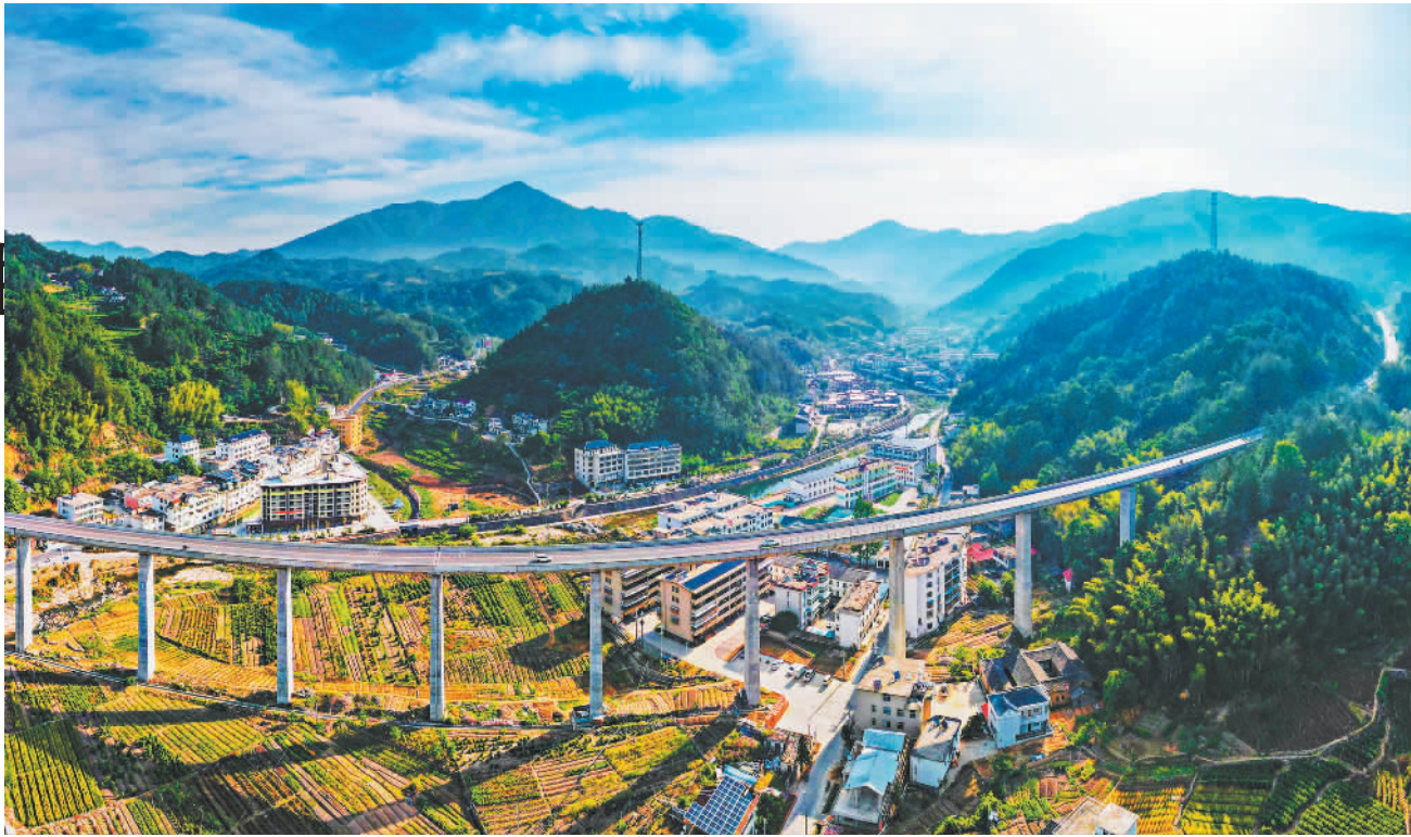
安徽省安庆市岳西县,来榜大桥宛如长虹横跨山间,穿越村庄、田园、河流,与民居交相辉映,构成一幅大别山腹地美丽乡村画卷。吴均奇摄(中经视觉)
