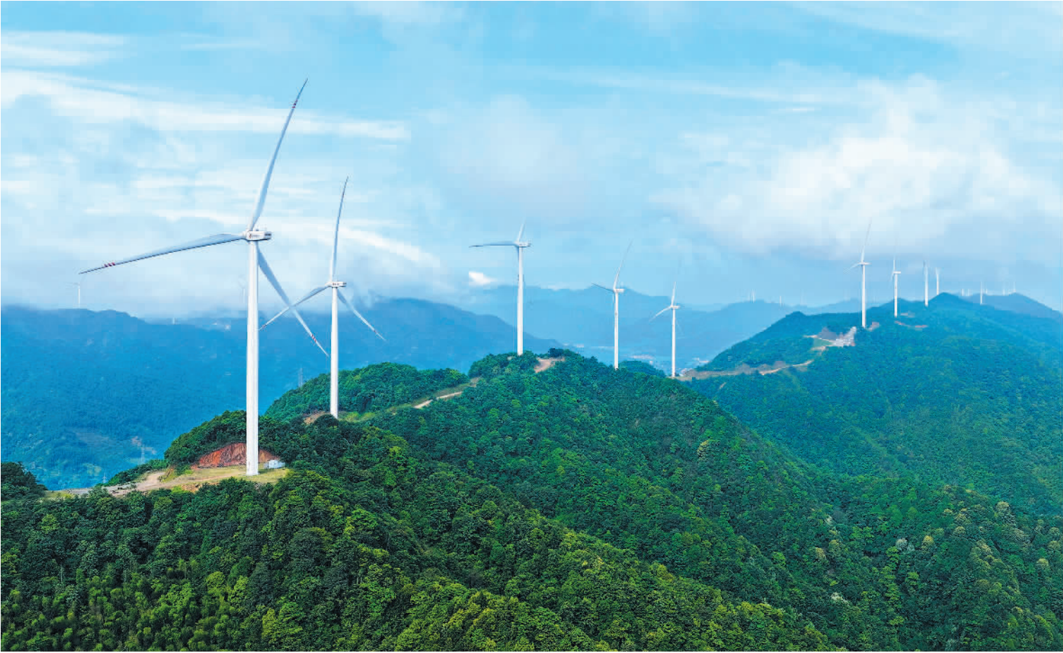
5月22日,位于江西省吉安市泰和县老营盘镇的高山风力发电场。近年来,当地充分利用高山风力资源,引进国家电力投资集团兴建高山风力发电场,产生清洁能源,助力低碳减排,推动绿色发展。 邓和平摄(中经视觉)
