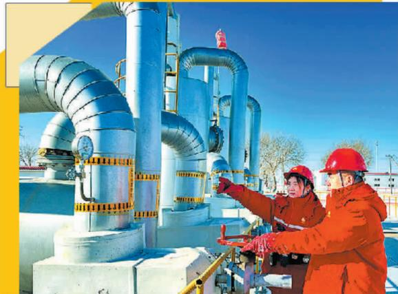
吉林油田二氧化碳开发公司员工在二氧化碳驱油与埋存循环注入站的伴生气预处理装置区巡检。安 宁摄(中经视觉)
