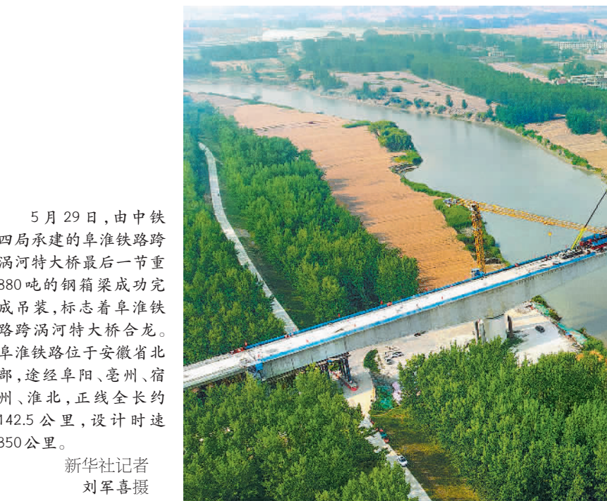
5 月 29 日，由中铁四局承建的阜淮铁路跨涡河特大桥最后一节重 880 吨的钢箱梁成功完成吊装，标志着阜淮铁路跨涡河特大桥合龙。阜淮铁路位于安徽省北部，途经阜阳、亳州、宿州、淮北，正线全长约 142.5 公里，设计时速 350 公里。
