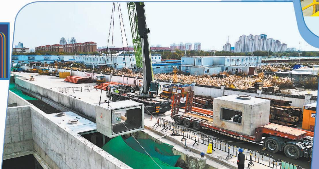
天津地铁11号线电缆迁改应用预制电缆井现场。
