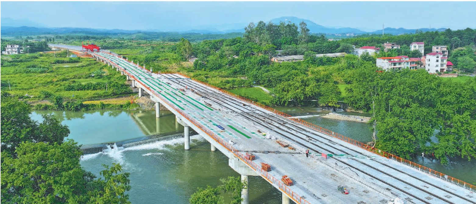
6月3日,湖南省永州市零(陵)道(县)高速道县段贵头大桥施工现场。该高速北接永零高速,南至G76厦蓉高速,建成后将成为呼北高速粤港澳大湾区支线,打通永州向南接广西、广东通道,改善湘南山区交通状况。何红福摄(中经视觉)
