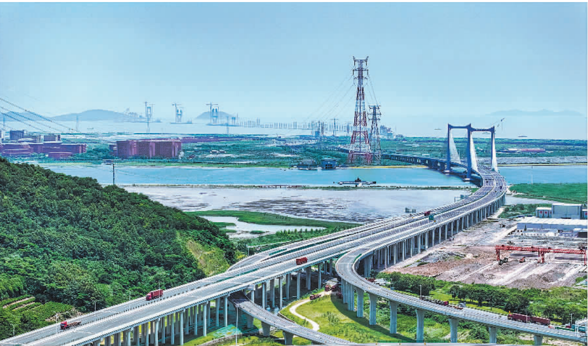
浙江宁波舟山港六横公路大桥一期正式通车
