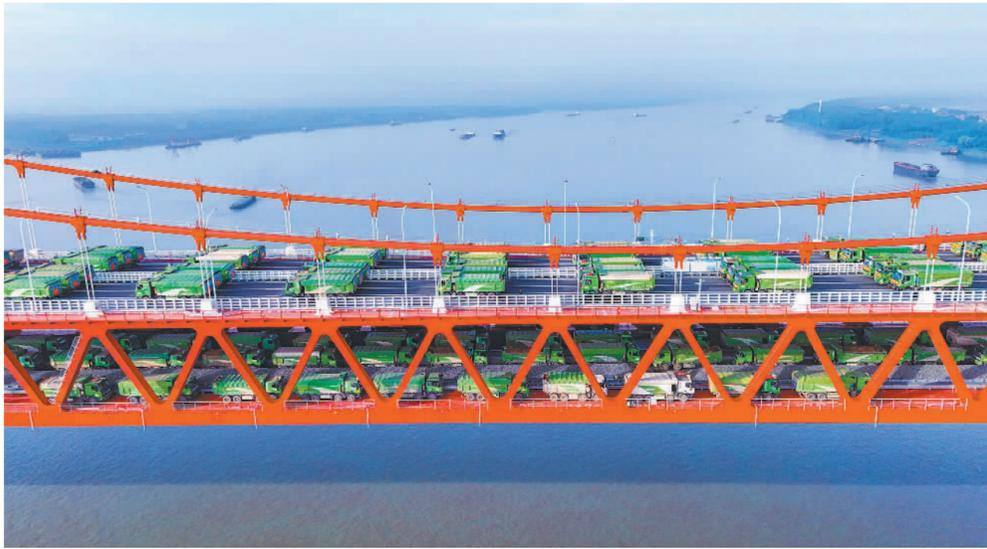
日前,在安徽铜陵G3铜陵长江公铁大桥建设现场,中铁桥隧技术公司工程技术团队在有序实施大桥合建段主桥荷载试验。该大桥融合高速公路、城际铁路、货运铁路3种过江功能,建成通车后对于提升区域过江通道通行能力、助力区域经济社会发展和促进长三角互联互通等具有重要意义。 储著摄(中经视觉)
