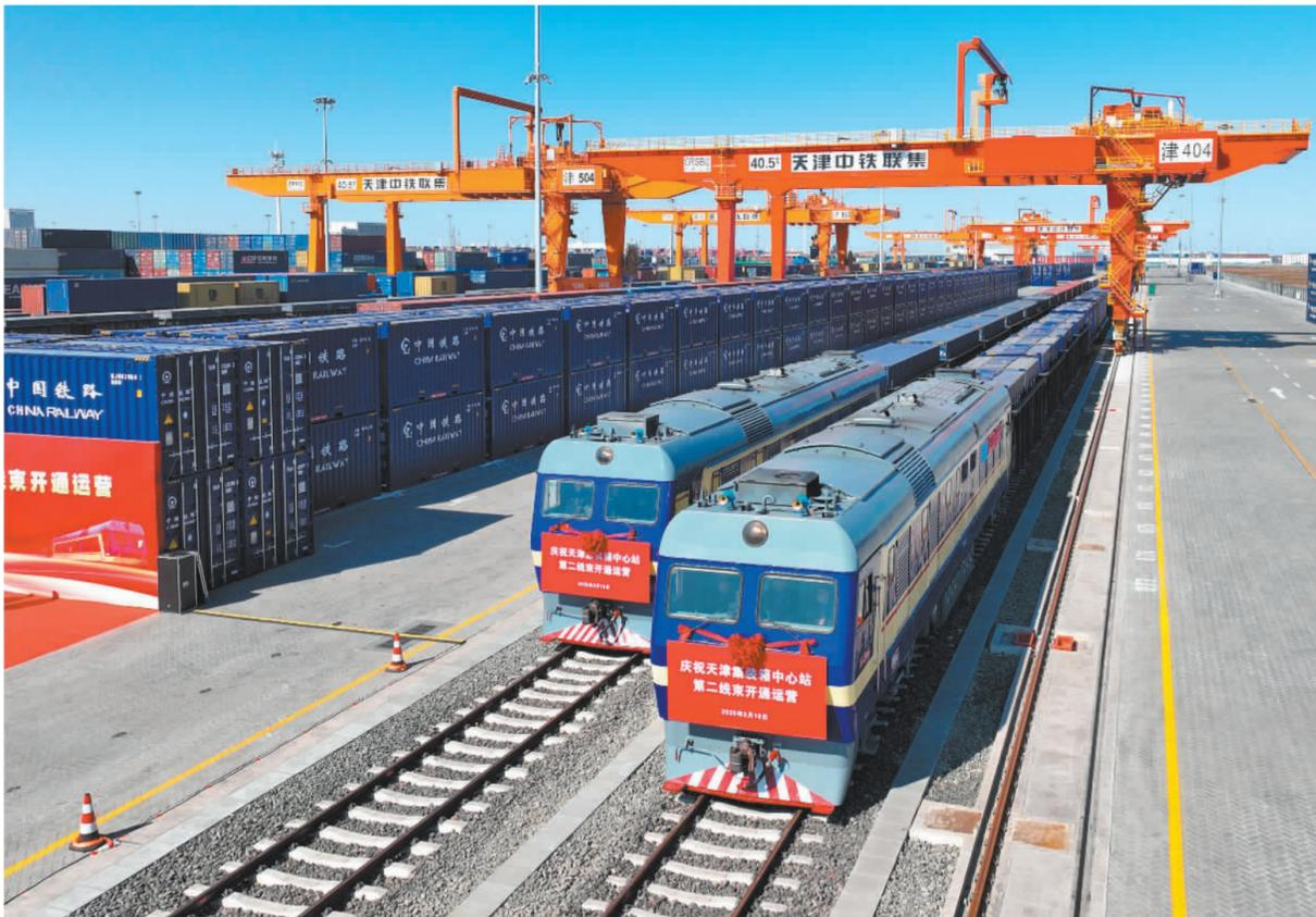
▲3月23日,天津港第二集装箱码头一派繁忙。该码头依托单小车岸桥、智能解锁站、智能水平运输机器人、水平运输边装卸堆场等实现全流程自动化、智能化集装箱作业,泊船时效率最高达329箱/小时。
