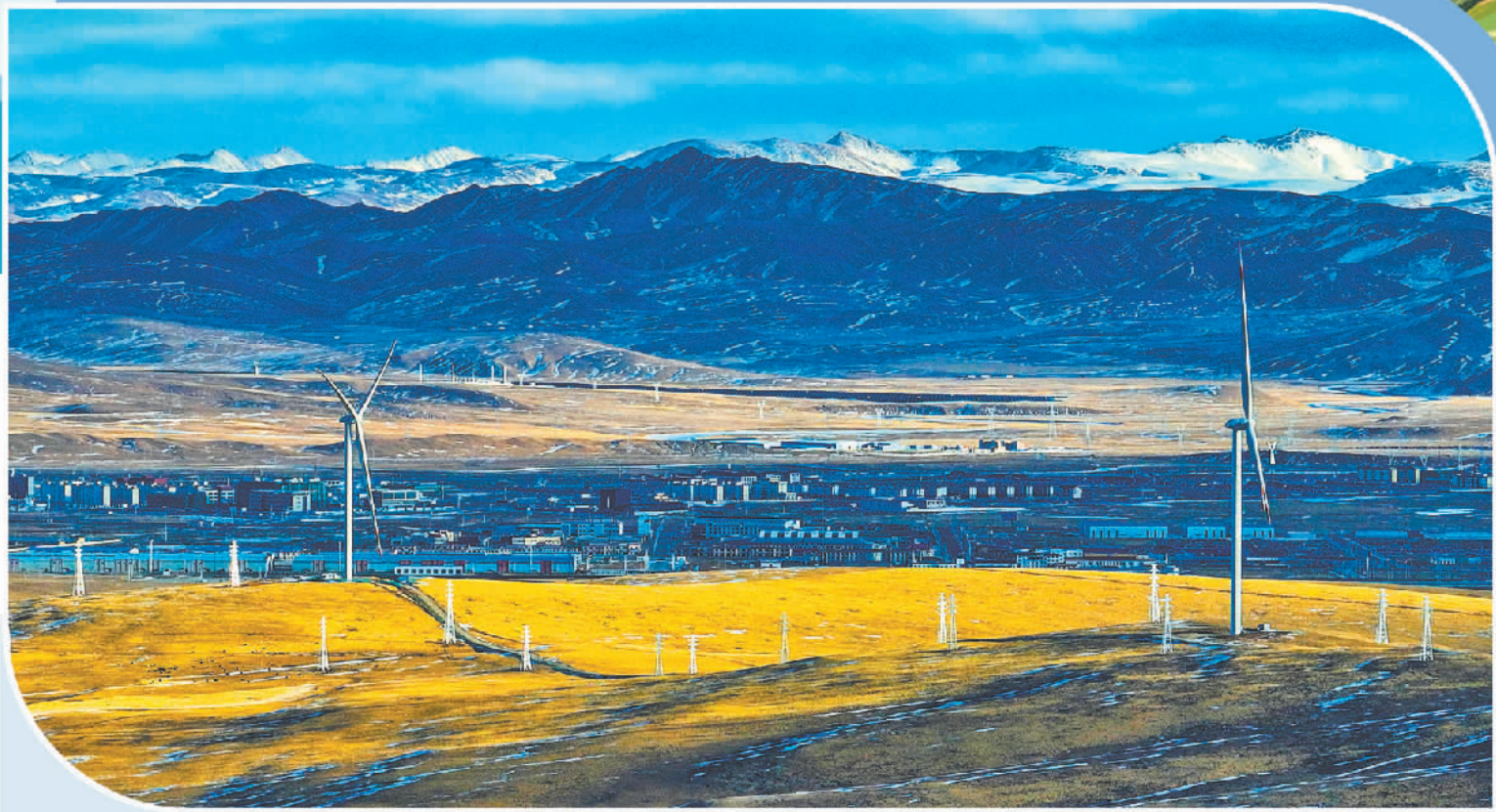
在浙江援藏工作队助力下,国家能源集团那曲市色尼区欧玛亭嘎100兆瓦风电项目2023年底建成投产。
