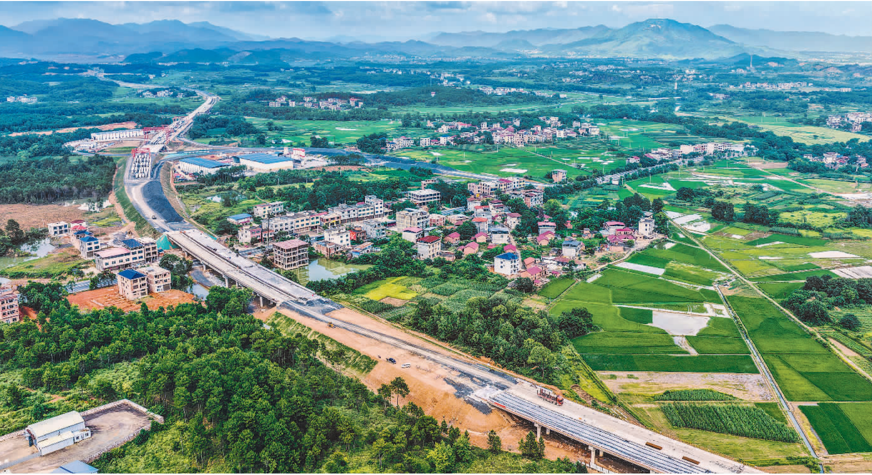
6月13日,湖南省永州市零(陵)道(县)高速道县段建设现场,工人正在加紧施工。该项目是湖南省高速公路网永州—贺州高速公路的组成部分,建成通车后,将形成呼北高速粤港澳大湾区支线,促进区域经济发展。
