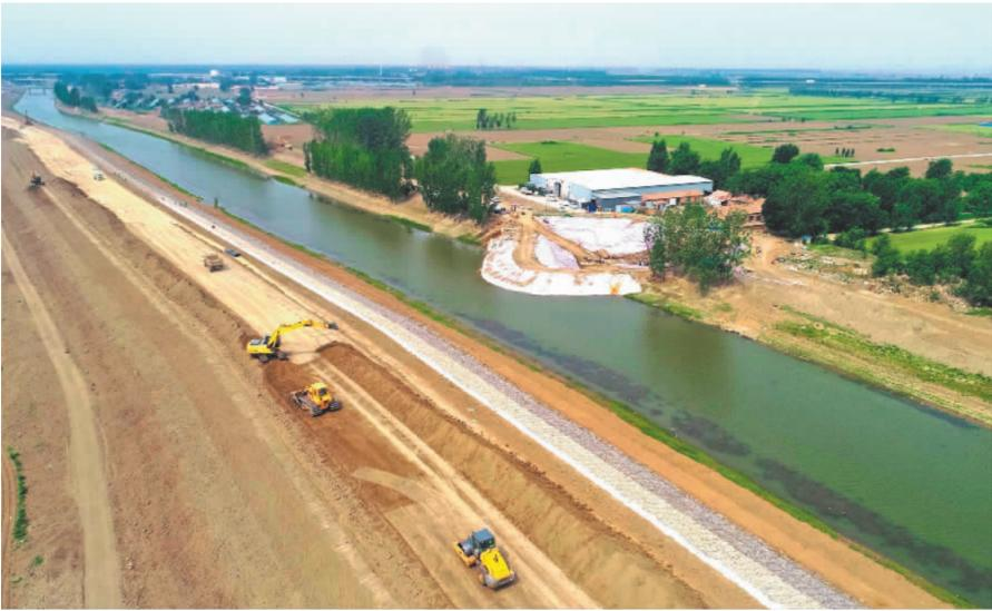
◀6月16日,天津东淀和文安洼蓄滞洪区工程子牙河段堤身加高完工,为安全度汛奠定基础。
