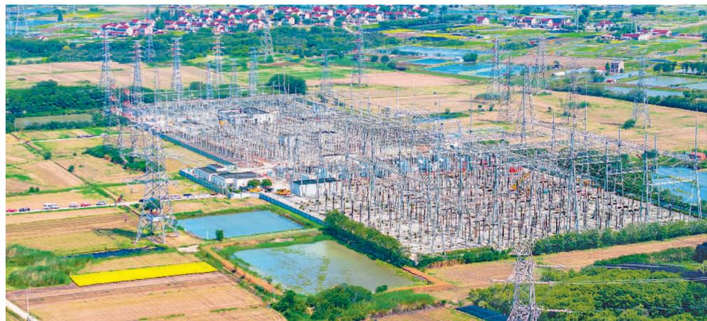
6月19日,江苏常州茅山500千伏变电站扩建工程正式投运,标志着江苏省今年迎峰度夏电网重点工程已全部建成投运,将显著增强电网供电能力,为经济社会高质量发展提供保障。此次扩建新增一台1000兆伏安主变压器,使该站主变压器增至3台,总输送容量达3000兆伏安。
