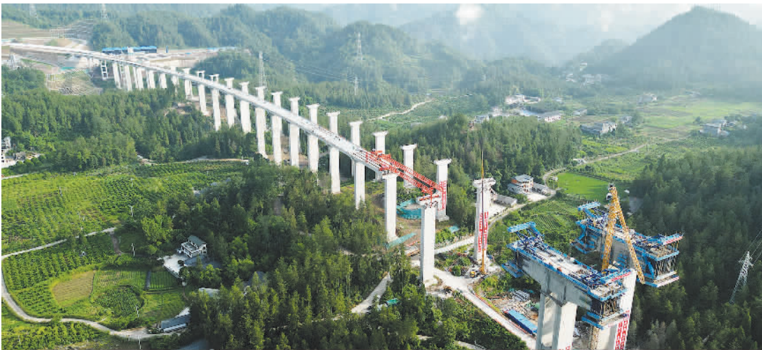
6月24日,湖北省恩施土家族苗族自治州利川高速公路大河特大桥建设现场,工人正加紧施工。利成高速公路预计2026年建成通车。李维君摄(中经视觉)
