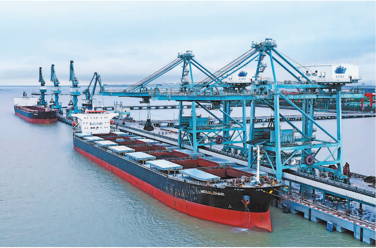
6月25日,货轮在浙江省温州港乐清湾港区煤炭码头卸运电煤。进入“迎峰度夏”电煤保供时期,乐清湾港区加大煤炭运输组织力度,开通电煤“绿色通道”,实现随到随卸、及时转运,确保电厂发电用电煤需求。蔡宽文摄(中经视觉)
