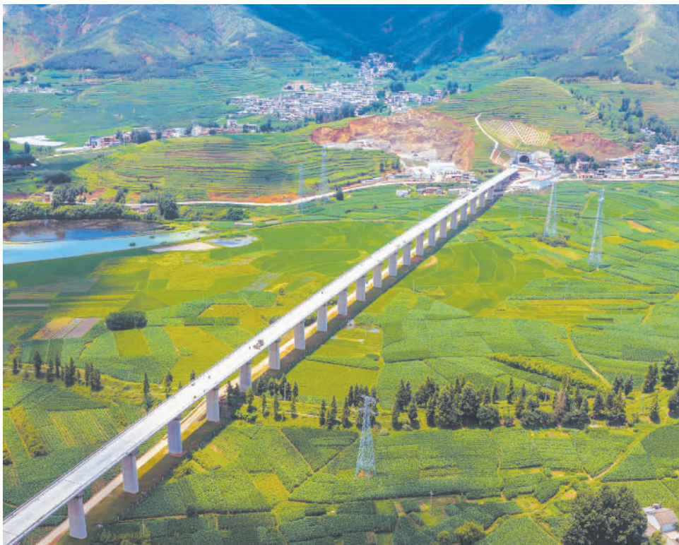
6月30日，渝昆高铁控制性工程、全线最长单洞双线隧道——宝云隧道贯通。该隧道位于云南省曲靖市会泽县，全长16.8公里，是渝昆高铁首座贯通的16公里以上特长隧道。至此，渝昆高铁云南省内隧道已贯通41座。陈 畅摄(中经视觉)
