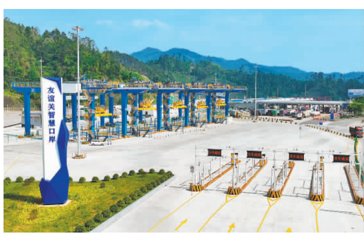
中越友谊关——友谊智慧口岸中方项目现场
