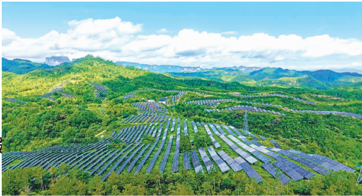
位于浙江省台州市仙居县上张乡的一处农光互补光伏发电站。近年来,仙居县上张乡坚持党建引领、绿色发展,流转荒山、荒地,引进建设光伏发电项目,助力经济发展、乡村共富。王华斌摄(中经视觉)
