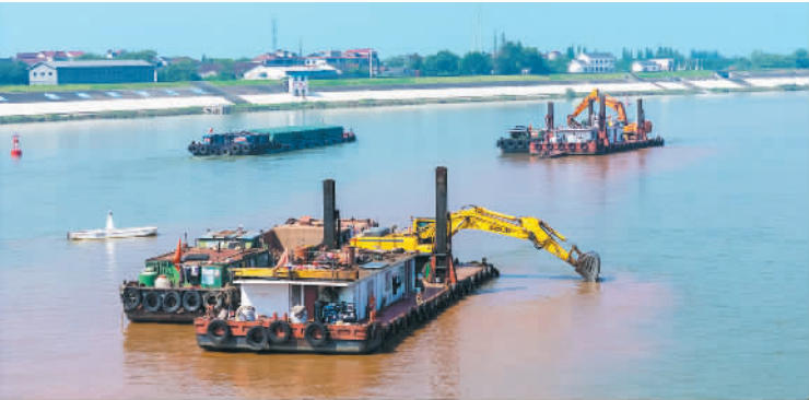
▲6月27日,浙江金华市婺城区衢江航道上,钱塘江三级航道整治工程船在进行航道疏浚作业。 胡肖飞摄(中经视觉)
