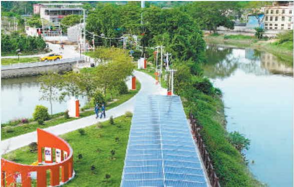
南方电网广东揭阳普宁局广太供电所党员服务队对供电区域内分布式光伏项目进行巡视，做好设备隐患排查、综合能源咨询等延伸服务，提高光伏发电可靠性
