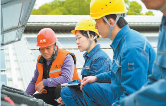
南方电网广东揭阳惠来供电局工作人员走访当地锦鸿印染制衣有限公司5.6兆瓦分布式屋顶光伏发电项目，实地了解项目发电效能及设备运行情况
