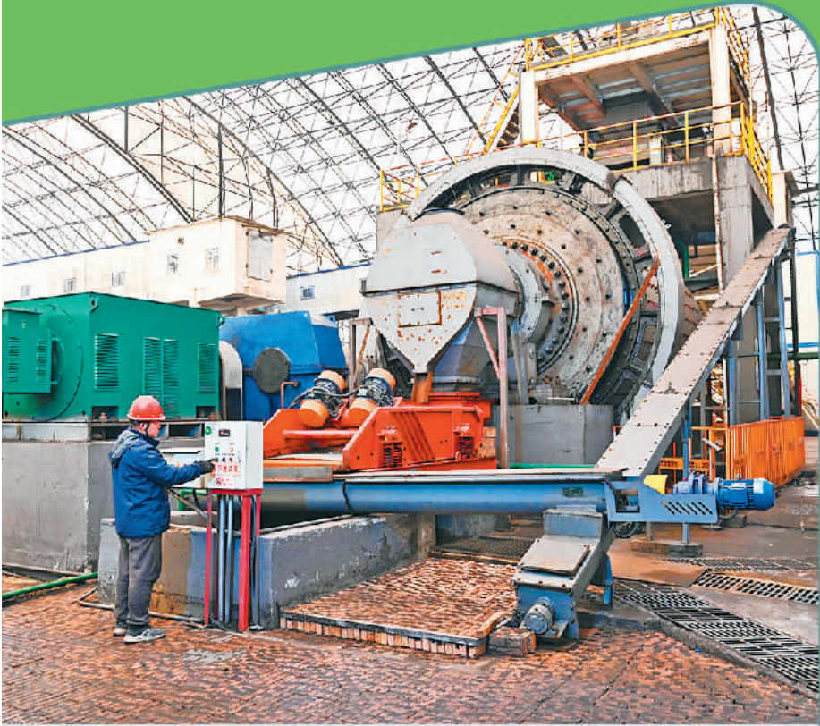
在山西霍尔辛赫煤业煤矸石球磨制浆区，员工正操作煤矸石除渣机。
